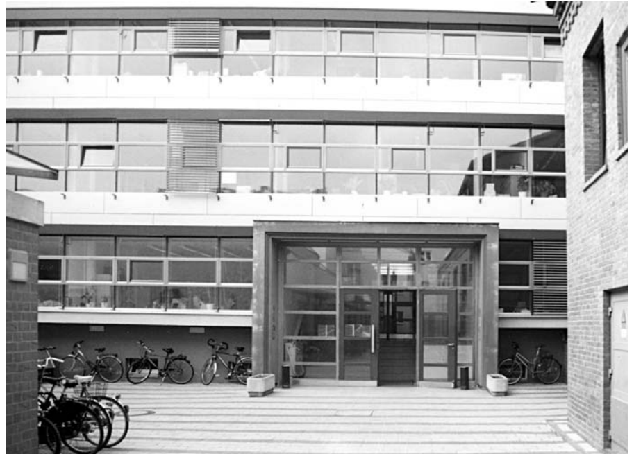
Potsdam, Lindenstraße 6. Hier befindet sich eine Außenstelle des Amtsgerichtes Potsdam.
